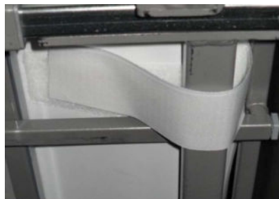
Foto 27 – Het opvulkussen bevestigen
